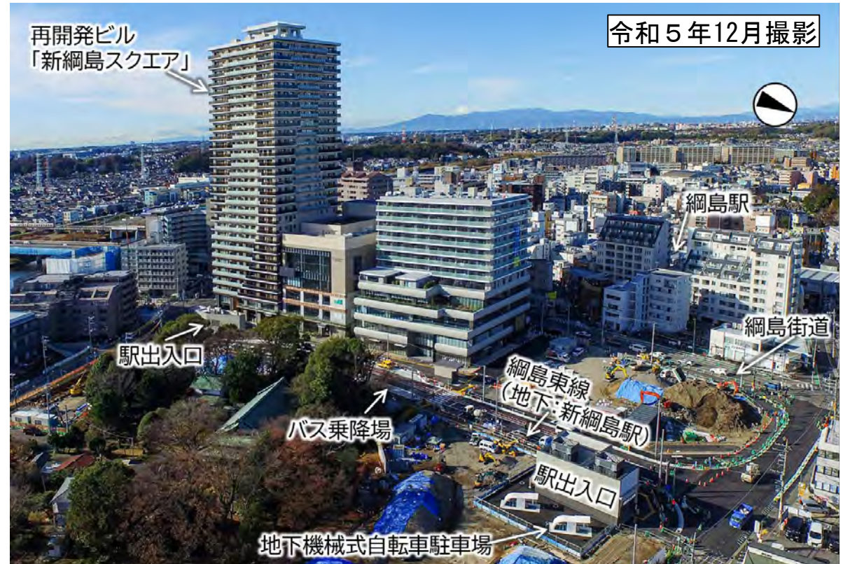
新綱島駅周辺地区の状況
