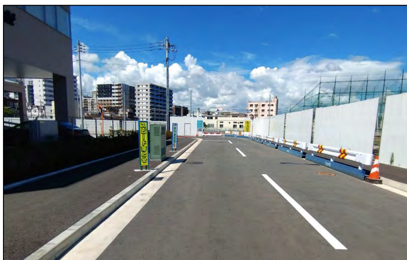
地区内道路の一部完成
